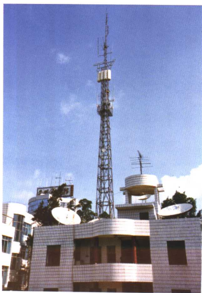
嵩明县光缆有线电视转播塔
