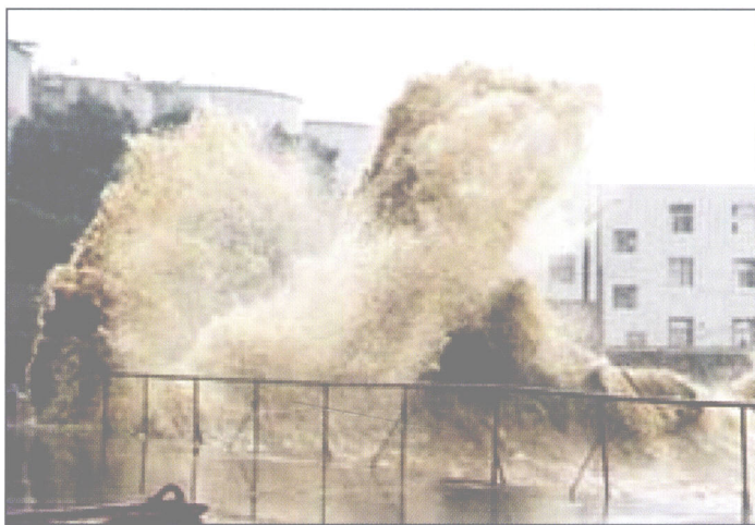
图4 沿岸民房受“麦莎”风暴潮威胁
