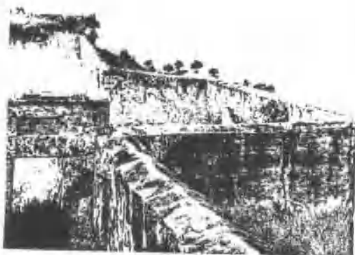
厦门城台炮台遗址
