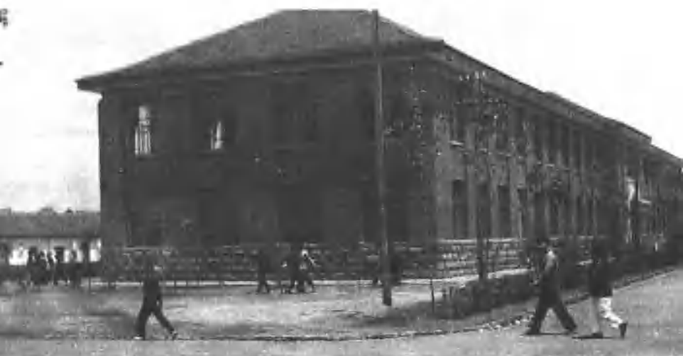
教学二号楼（1952年竣工）。
