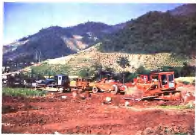
▲1988年施工队平整场地
