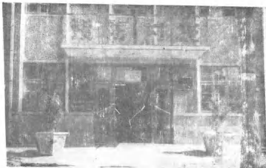
（照片七） 杞县卫生防疫站办公楼
