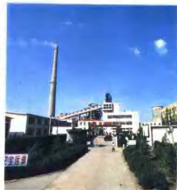
石家庄电厂装机容量24MW，年供热量130万大卡，是唐山市最早建设的热电厂
