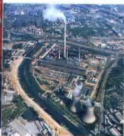
瓦房店电厂机组—1976年投产。机组为四机八塔，装机容量达200MW。该厂为十年规划荣获“大庆式企业”光荣称号
