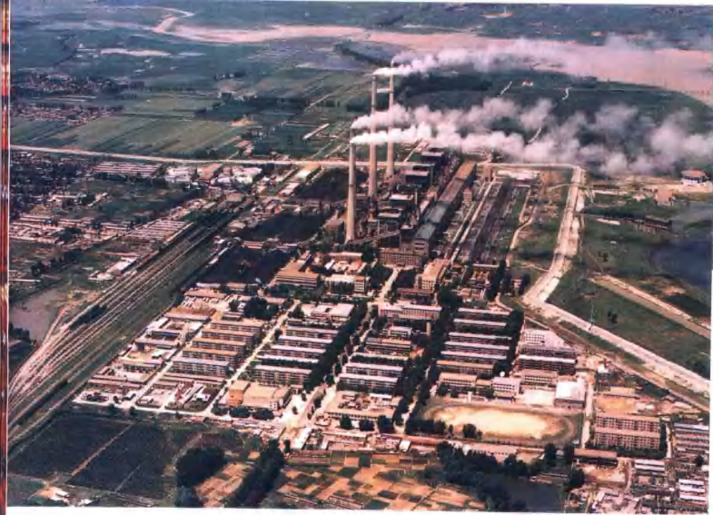
胜利发电厂机组—1973年。至1987年共安装机组4台，总装机容量149MW。1至4号机组为引进设备，5至8号机组为国产200MW机组
