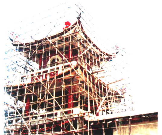
● 建设中的钟楼
