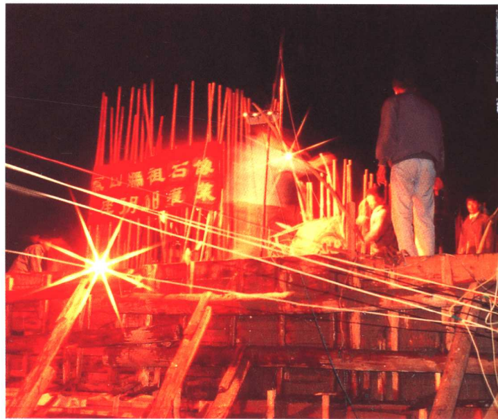
● 日夜战斗在施工工地的技术人员和工人们
