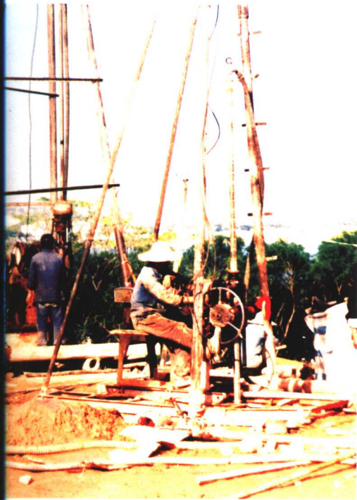
● 妈祖石像基础的钻探工地
