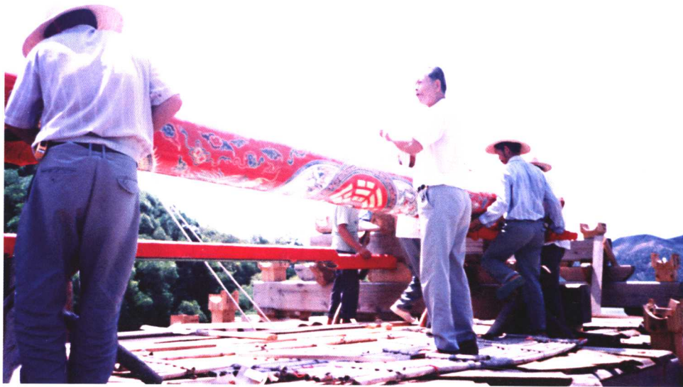
● 凤山祖庙脊梁安装
