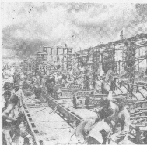
正在安裝的進湖閘。
