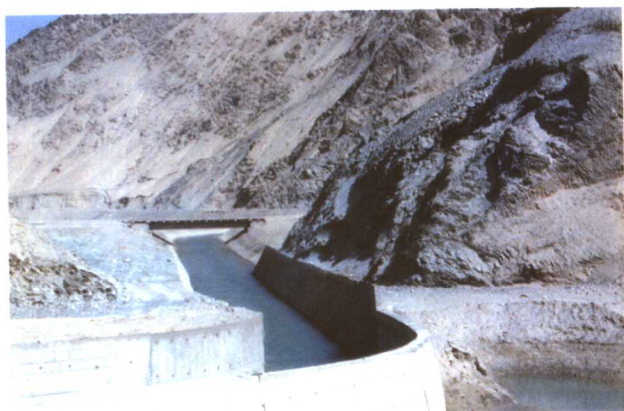
阿克苏温宿电站龙口明槽
