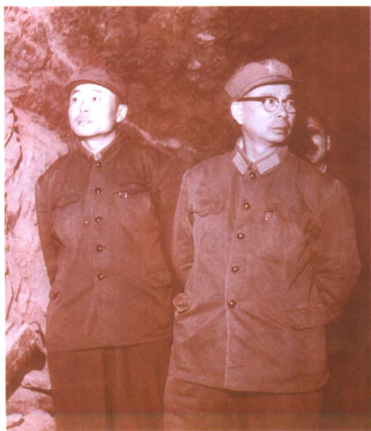
1976年5月铁道兵二指副司令员王万祥 （右）视察工三团西轮沟和哈拉盖隧道工地时 的情景。
