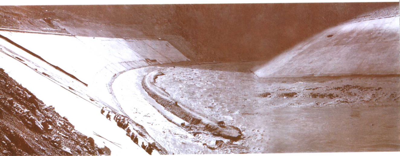
新疆海拔最高的塔什库尔干电站左右岸副坝
