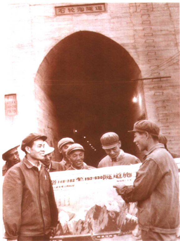
1976年建成的南疆铁路石轮沟隧道
