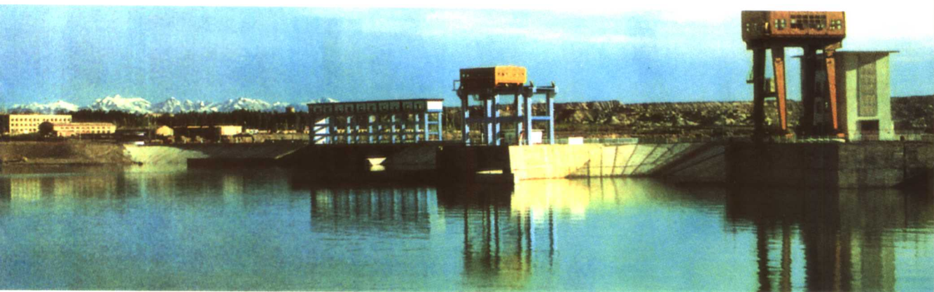
建成后的黑孜水库一角
