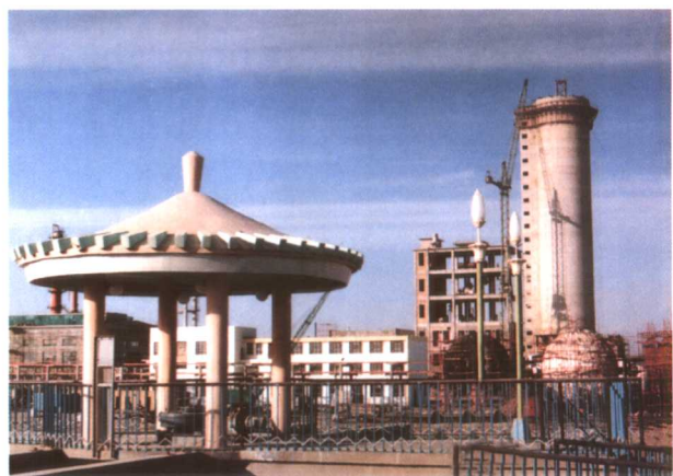
泽普石化厂污水处理厂一角
