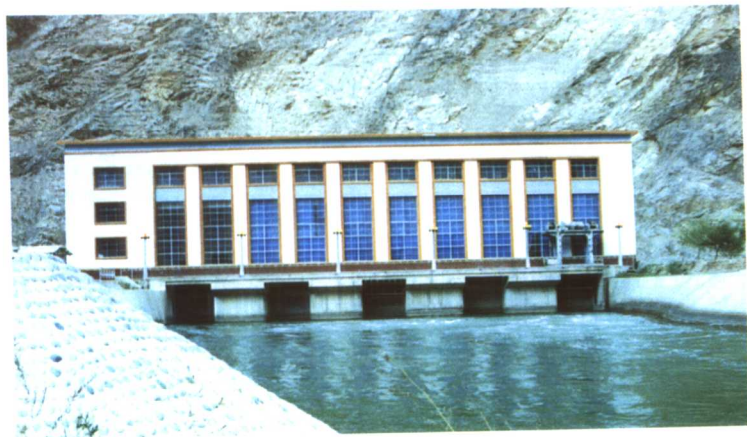
铁门关水电站厂房外景
