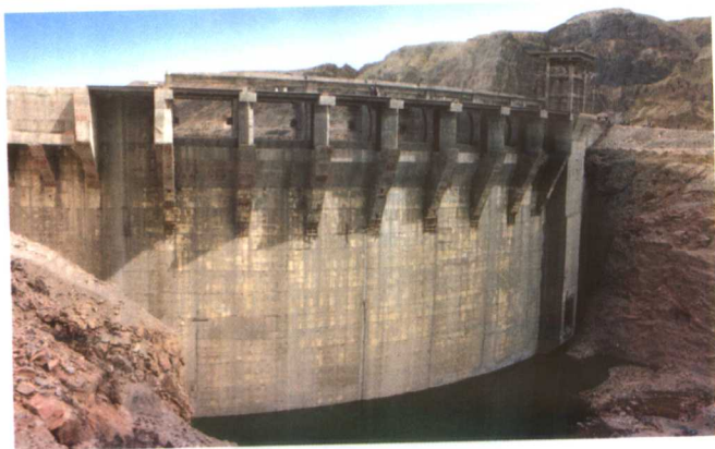
和静大山水电站
