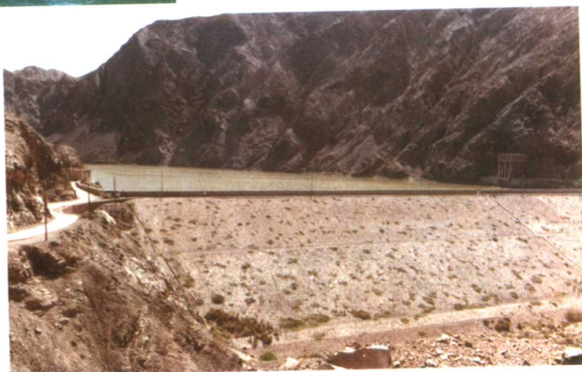
铁门关水电站大坝
