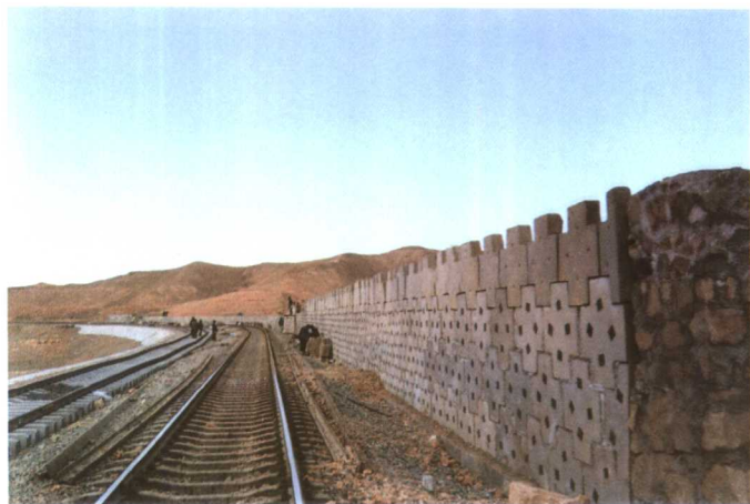
兰新复线及建设中的挡风墙
