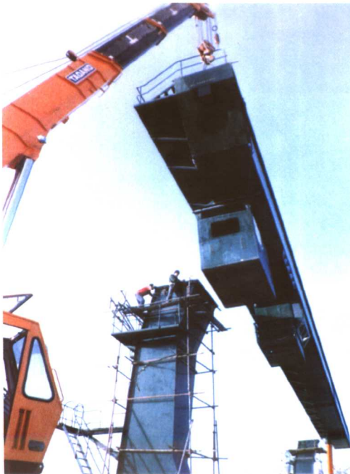
石油大二线 30 米跨 30T 龙门吊安装时的情景
