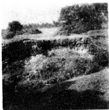
照片6—6 “沟尾泉”的潜蚀作用造成上部土体坍(崩)塌
