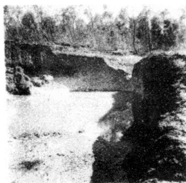
照片6—9 “沟尾泉”的潜蚀作用造成上部土体坍(崩)塌
