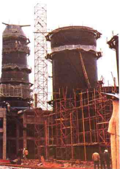
5余钢铁厂600立方米高炉 年底，高炉主体胜利竖起。
