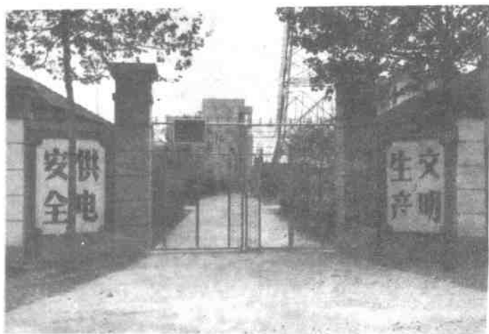
息县下庄变电所
