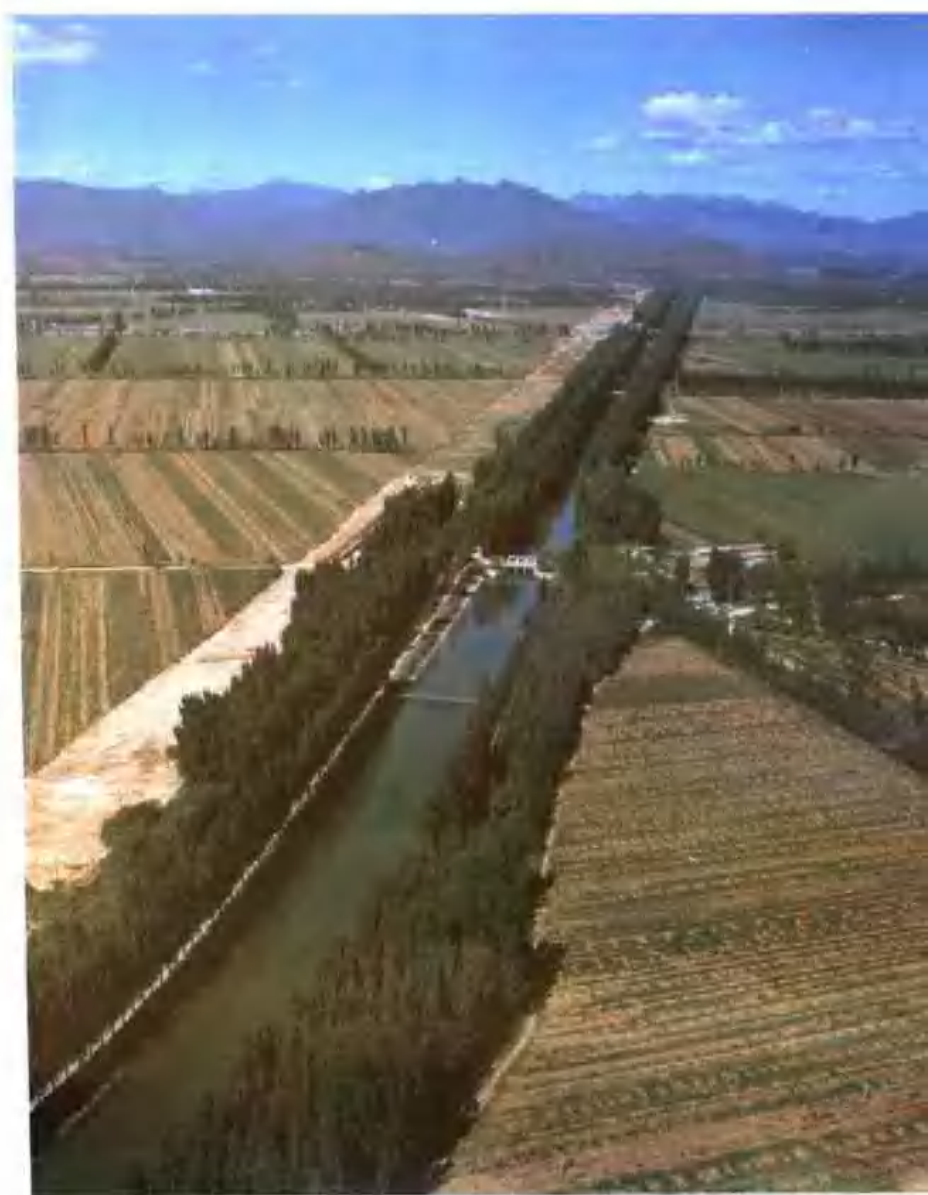
横贯北京五个区县最大 输水工程——京密引水渠
