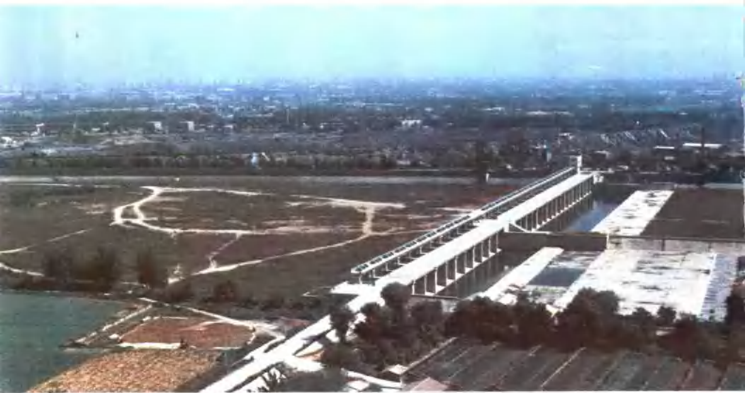
确保首都安全的永定河分洪枢纽工程——卢沟桥拦河闸及小清河分洪闸
