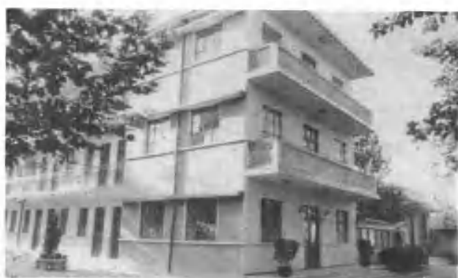
寿光县第二拖拉机配件厂办公楼
