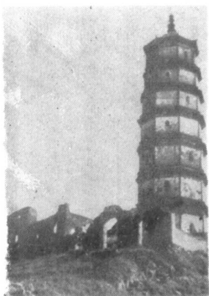
圖山峰頂古楞伊禪寺 被日軍焚燒後的斷壁殘垣。 (鎮江市博物館供稿)
