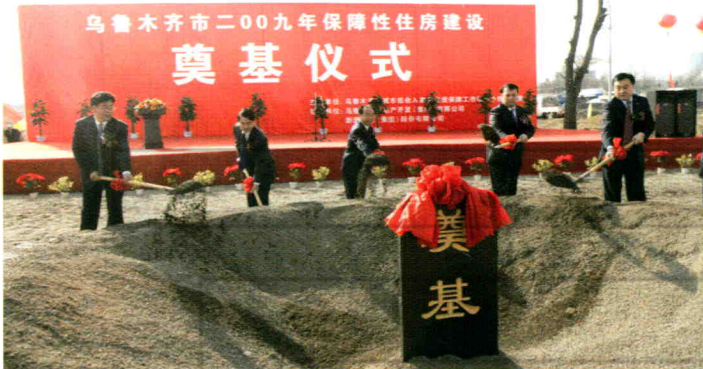
2009年3月30日，乌鲁木齐市2009年保障性住房工程在米东区开工 (摄影 刘俊)
