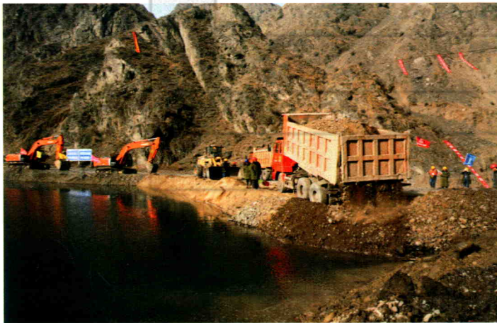
2009年11月5日，乌鲁木齐大西沟水库大坝主体工程开工 (摄影 刘新华)
