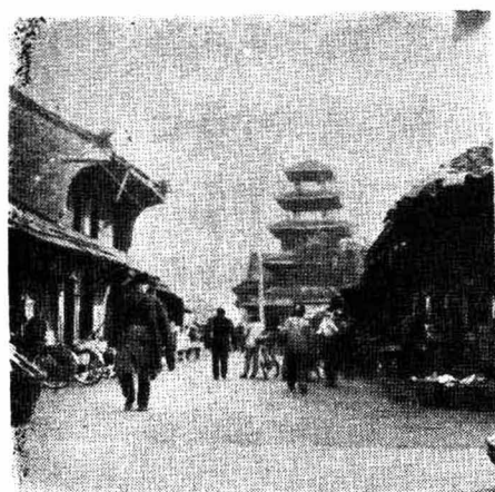
镇中心和消防楼
