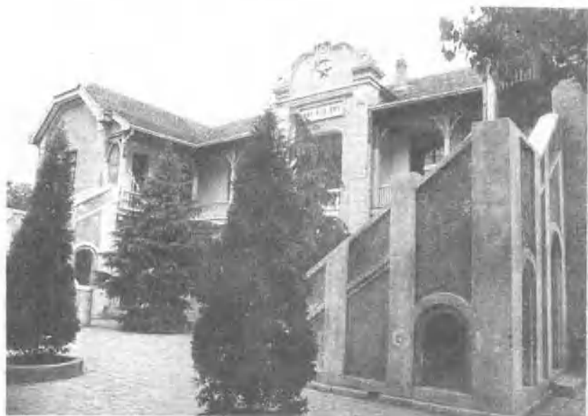
1931年建的曲阜师范学校教学楼
