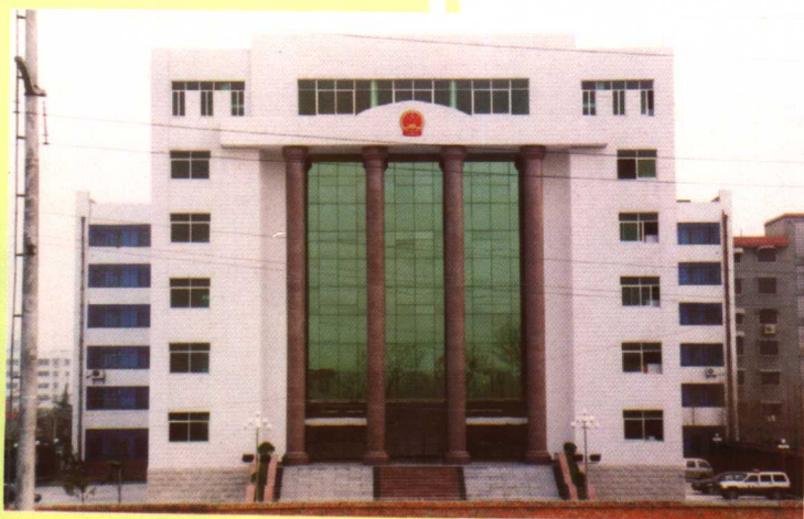
图为襄阳区人民法院审判大楼。
