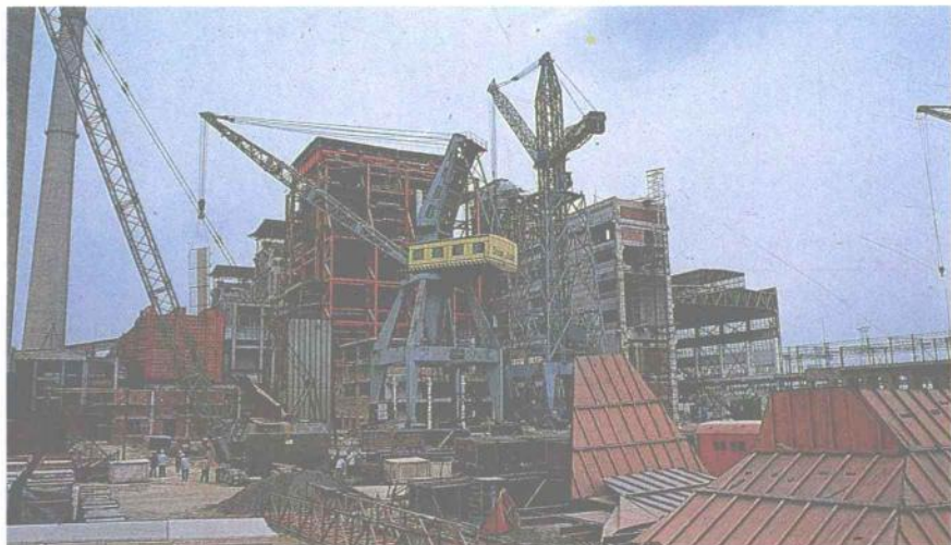
二期工程施工工地
