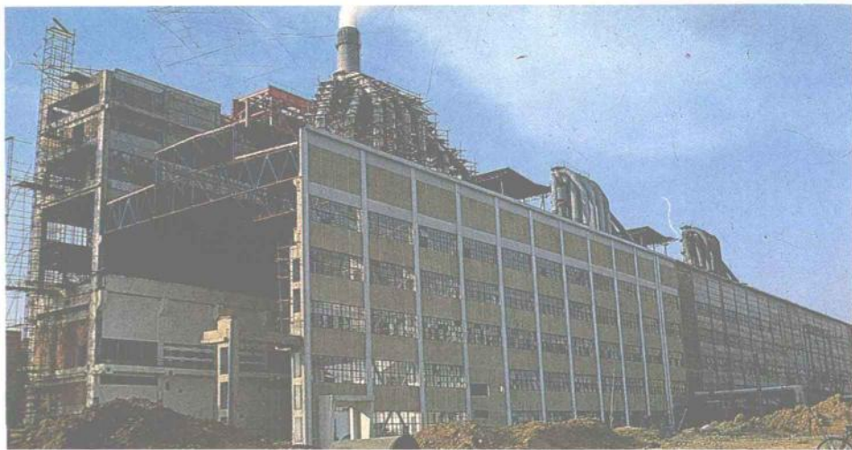
二期工程在扩建中
