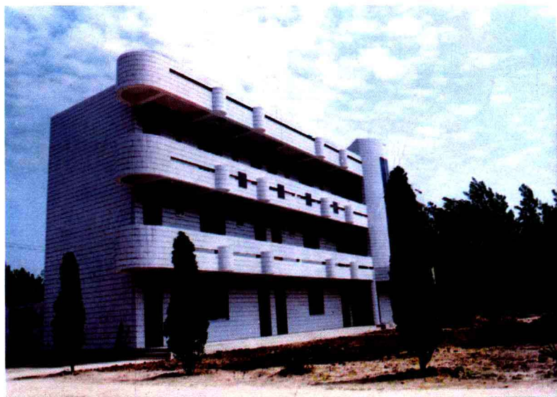
马圩中学教学楼
