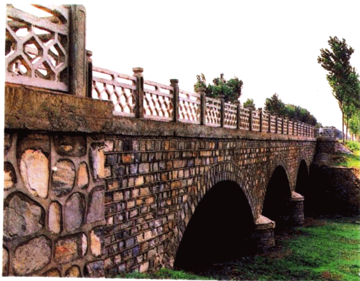
唐兴线新店子北石拱桥
