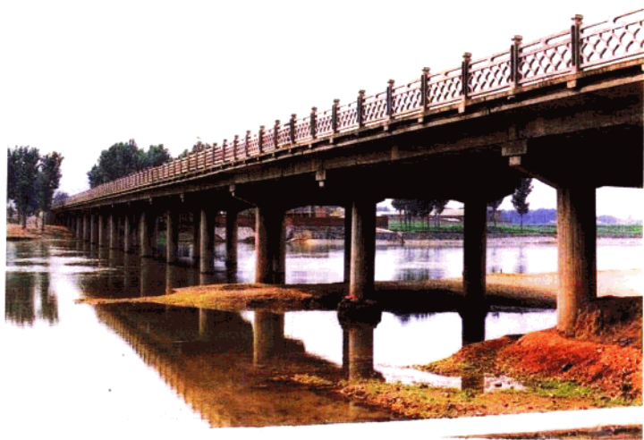
唐兴公路黎河大桥
