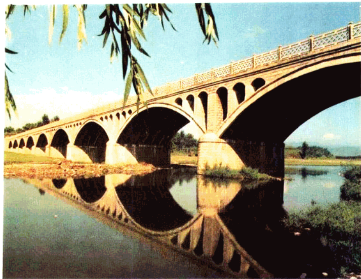
魏进河双曲拱大桥
