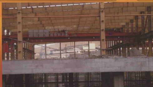
正在建设的工程
