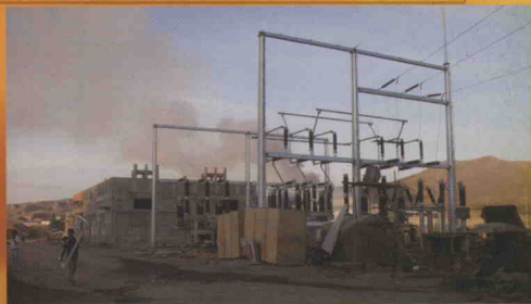
正在建设的工程
