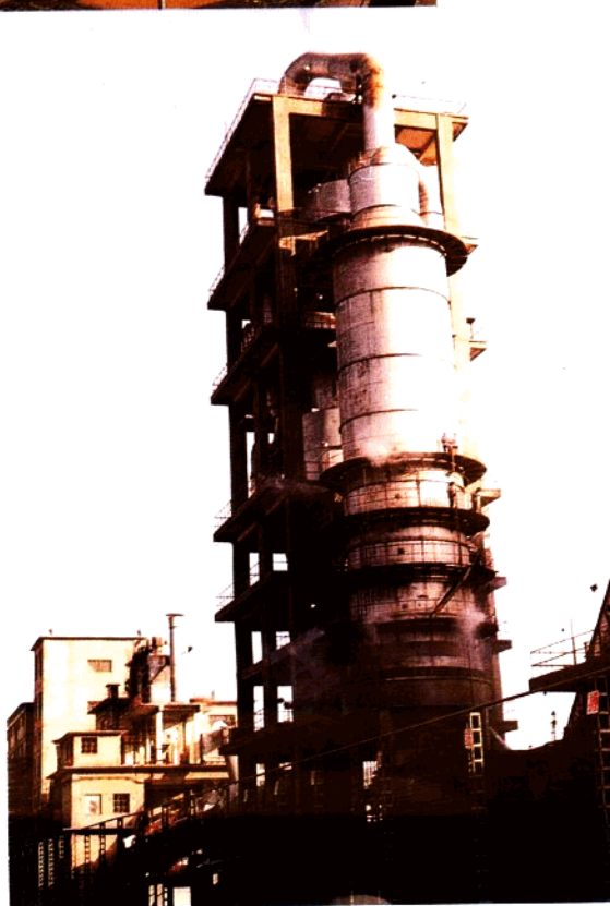
日产 700 吨熟料回转窑 四级预热器和增湿塔
