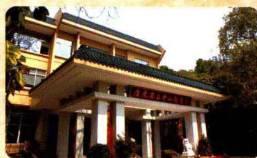
2010年12月，廣東省立中山圖書館 改擴建首期工程完工後開放。
