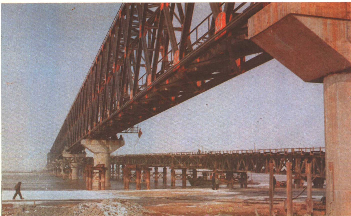
施工中的长东黄河铁路大桥
