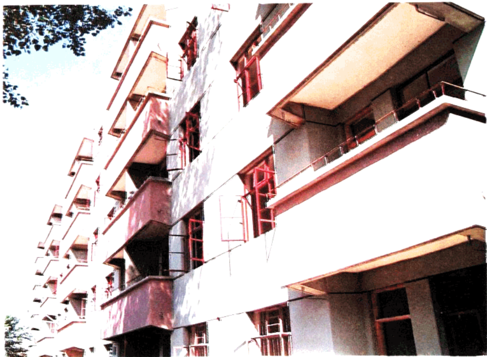
\\即将竣工的三号宿舍楼
