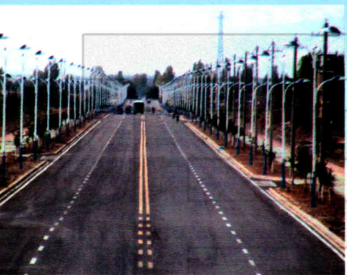
新建成的榆树沟镇镇区主干道
