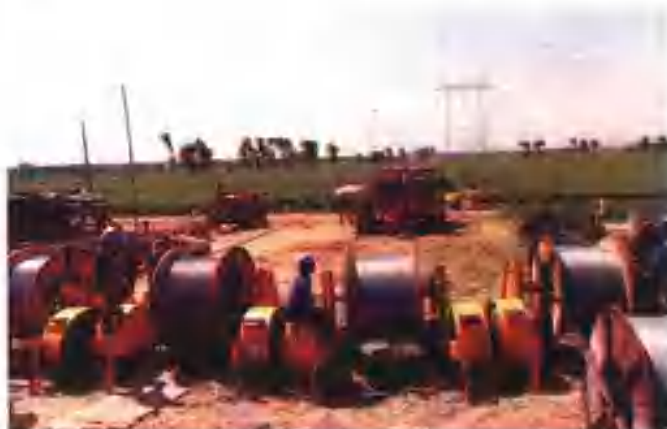
500KV 送电线路张力放线
