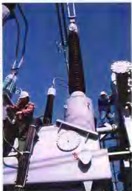
变电站设备安装
