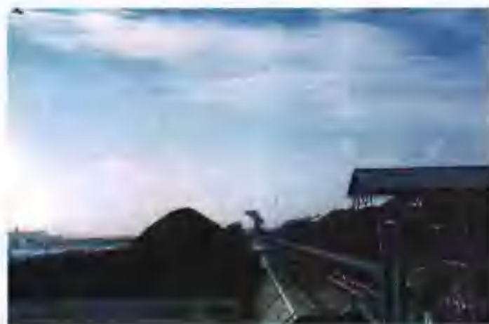
公司施工的交通部重点工程日照港5号煤堆场
