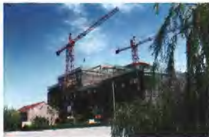
正在施工的写字楼工地
