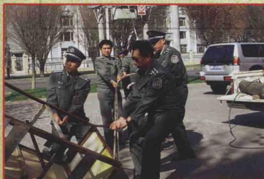
拆除违章建筑
