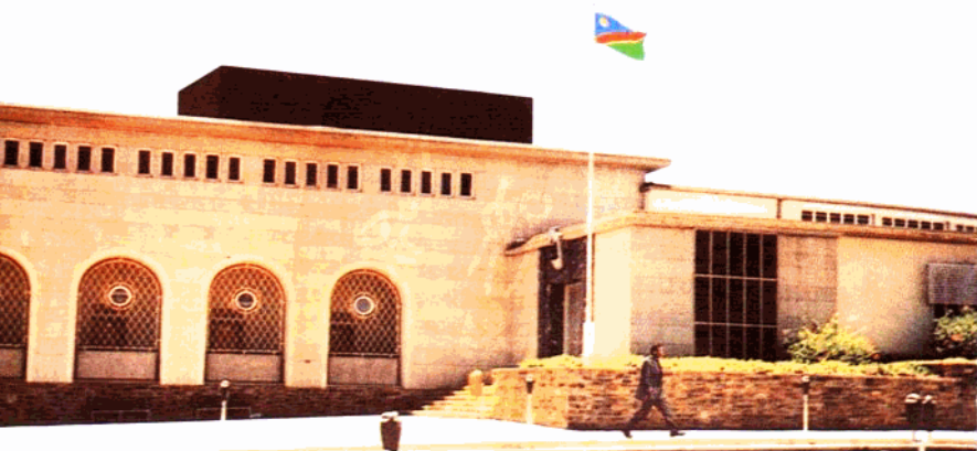
纳米比亚高等法院装潢工程
