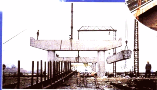
宝应运河大桥40m主跨的桥梁吊装
