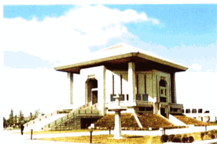
淮安周恩来纪念馆压桩工程
