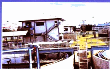
泰国吉泰污水处理厂工程
