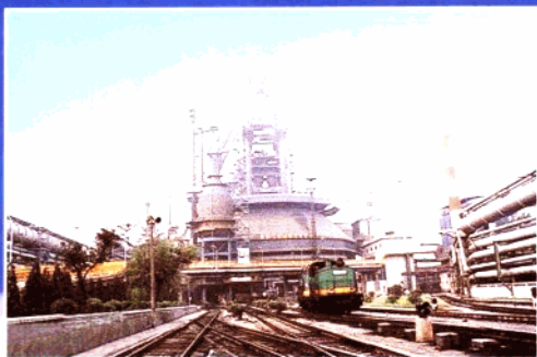
首都钢铁公司（设备安装）
