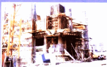
新加坡施工现场
