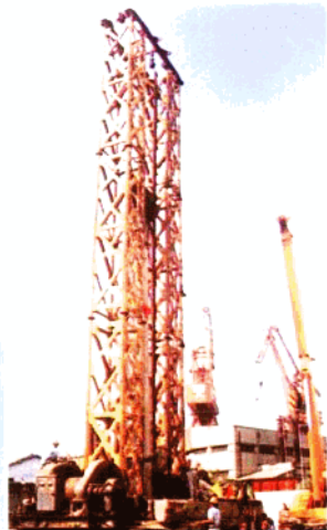
静力压桩施工现场
