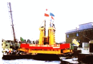
500吨液压桩机施工现场
