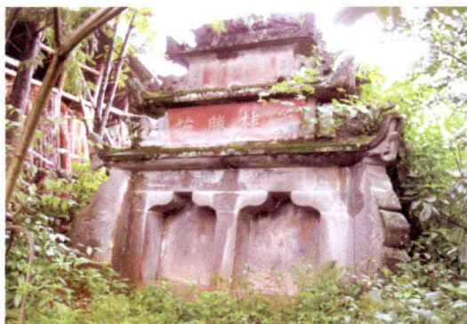
石柱縣悅峽鎮水橋村拖板場張公才舉（譚氏）墓，建於清光緒年間。
