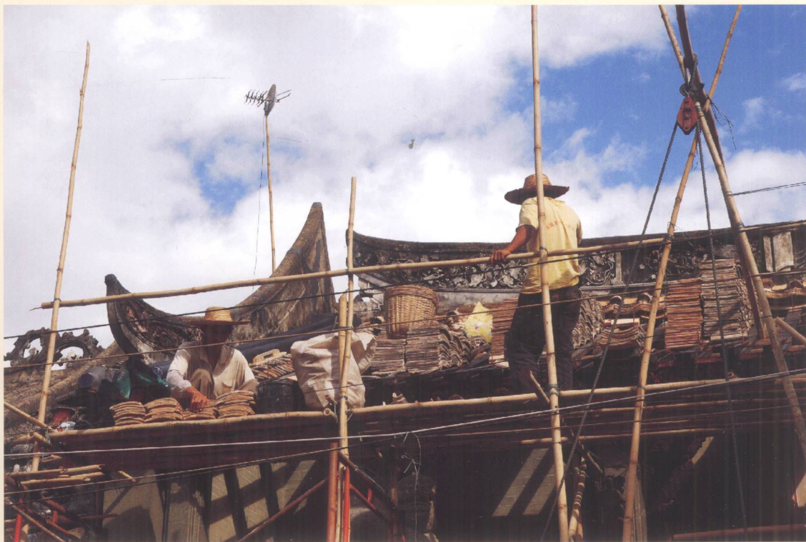
施工队对普查点进行屋顶补漏抢修
