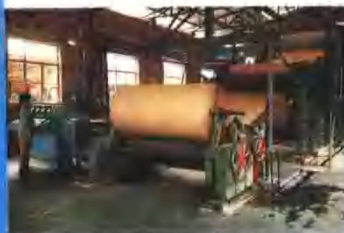
图为筑巢引凤，外引内联办起的瓦楞造纸厂车间。
