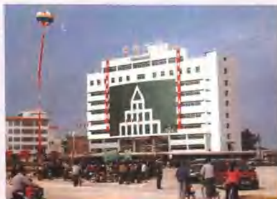
兴城镇市政大楼“兴城大厦”
