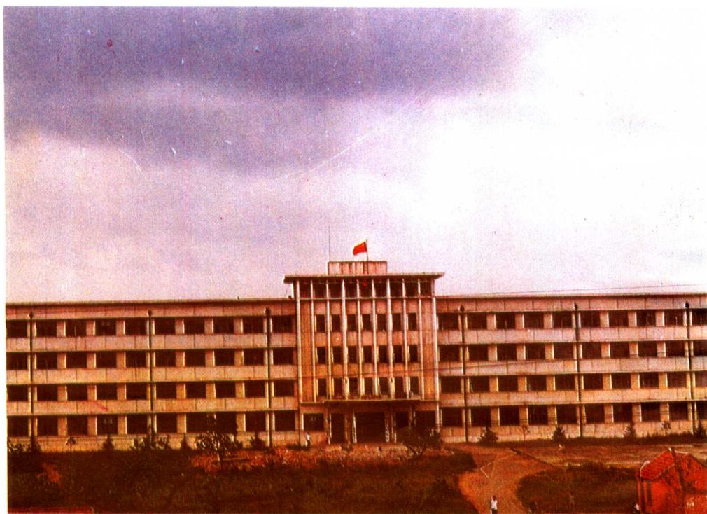
叶县人民政府办公楼
