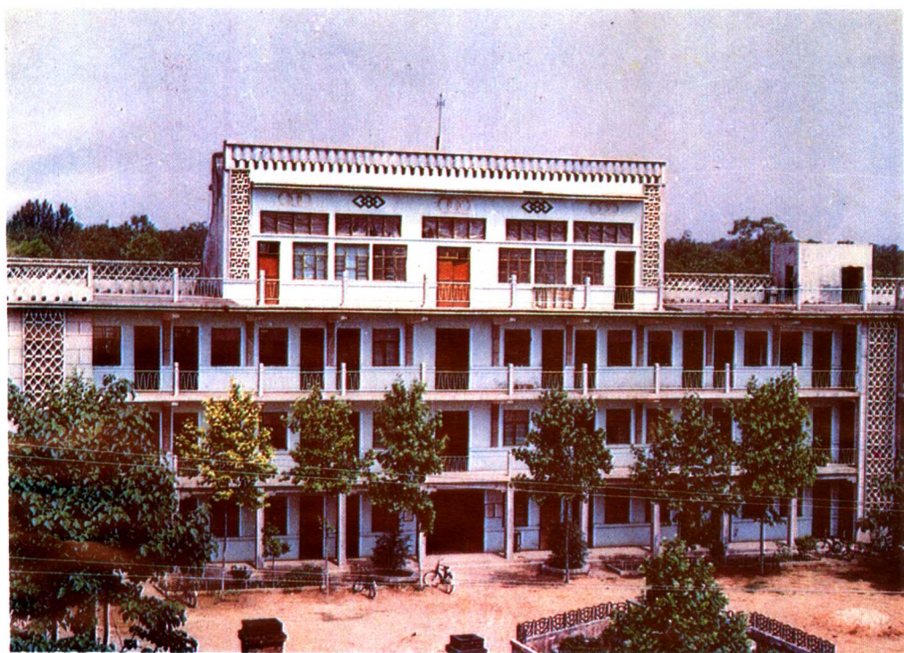
叶县城关镇人民政府办公楼
