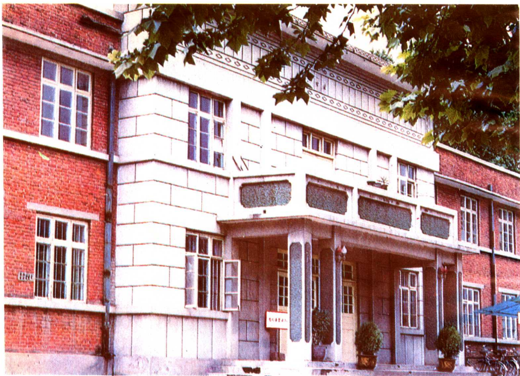
中国共产党叶县委员会办公楼
