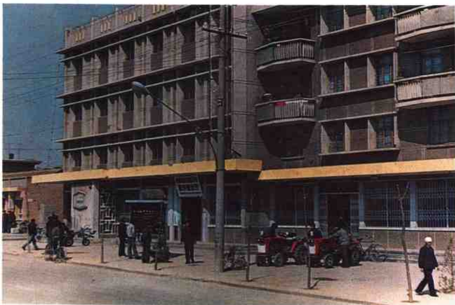
庆阳地区农业机械公司营业办公楼
