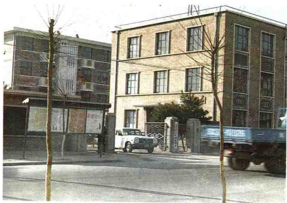
庆阳地区农业机械管理局办公楼
