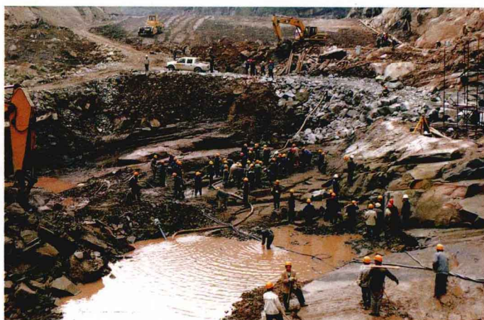
发电厂房施工现场
