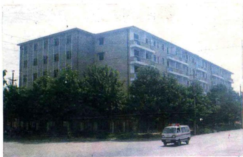
⑥ 中国第六冶金建设公司办公楼
