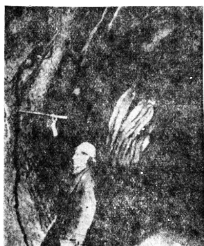
图21 水运隧道的剪切破坏
