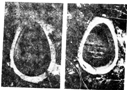
图10, 11 (左) 试验中的下水道管段, (右) 变形后情况, 周边内缘剥落
