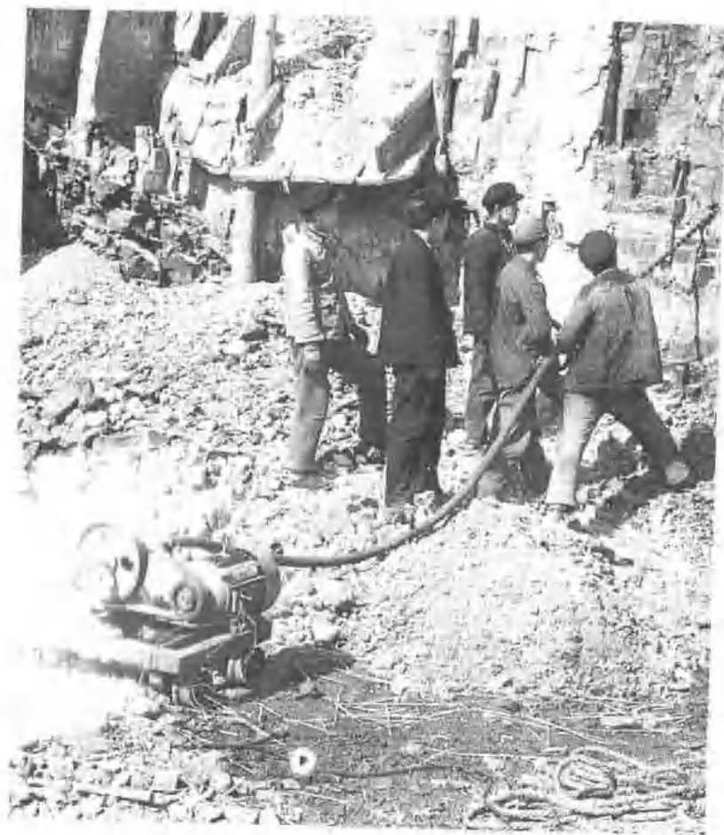
建矿初期自制打炮眼用的软轴电钻
