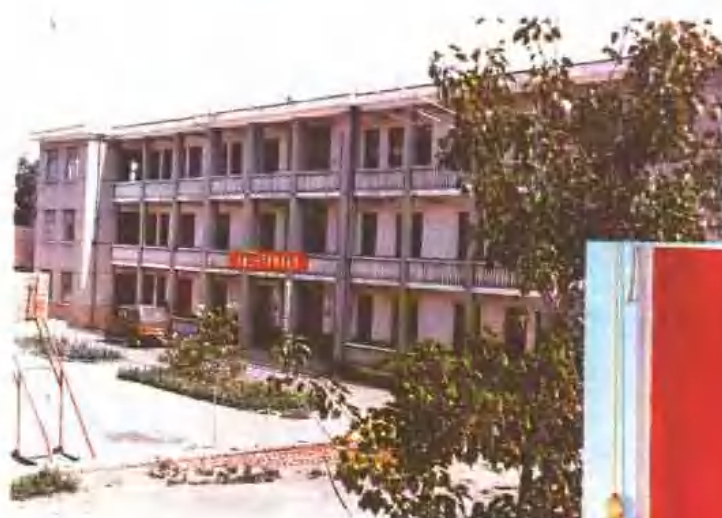
罗村矿区办公楼
