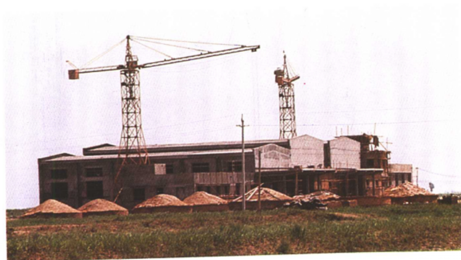
建设中的利津县水产冷藏厂
