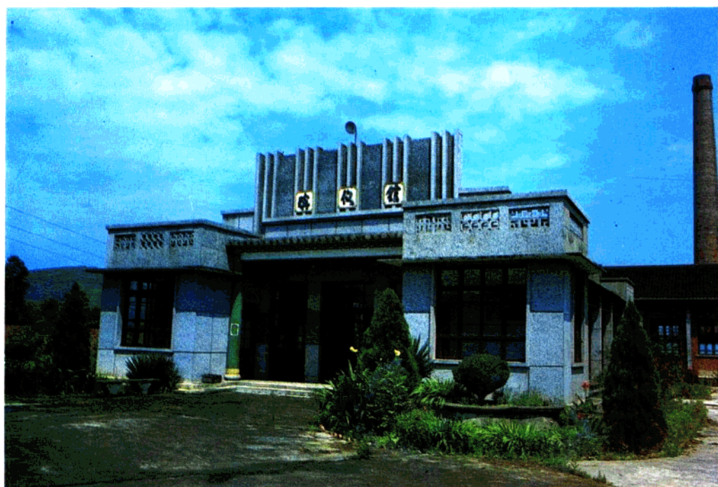
▼ 殡仪馆和火化车间
