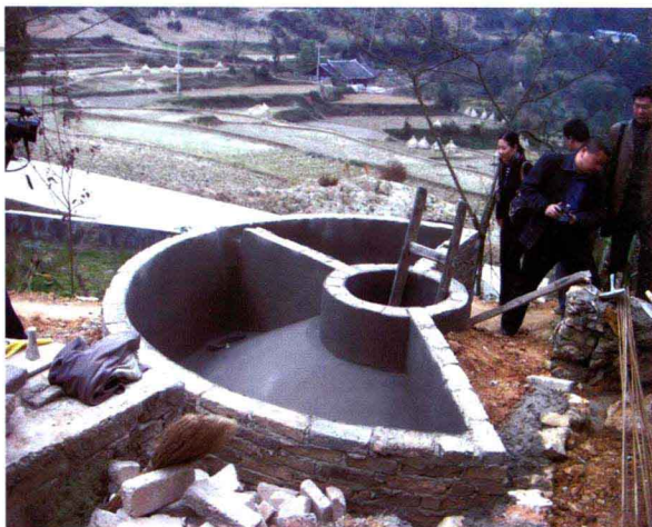
凯里市石龙寨在建的沼气池
