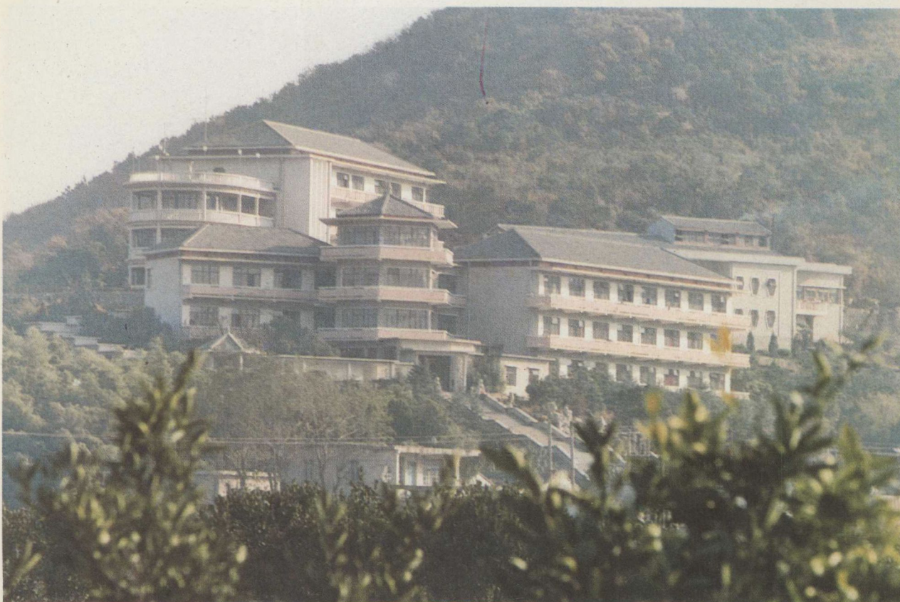
无锡纺织工人疗养院
