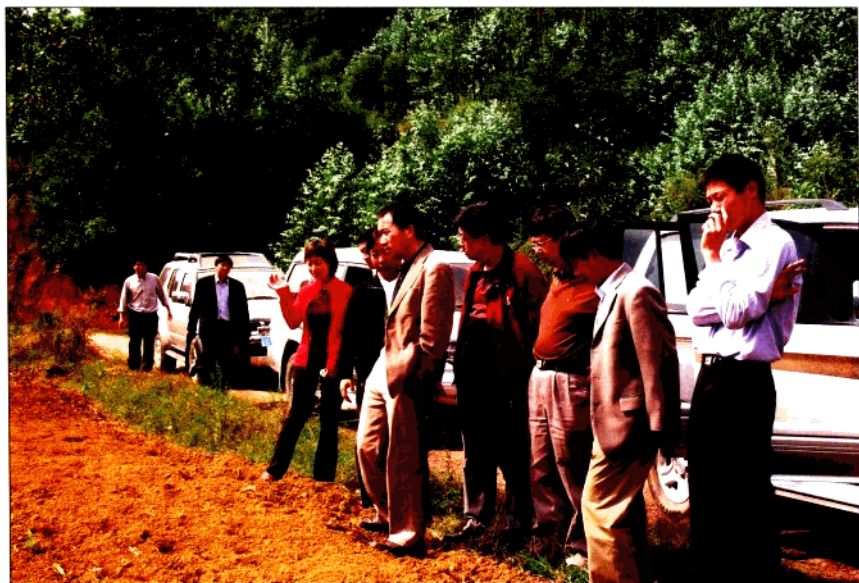
云南省通信管理局副局长赵宁（右五）在云南移动副总经理马奎（右四）的陪同下，深入到红河州边境县“兴边富民”移动通信工程施工现场了解情况。
