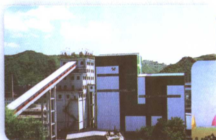
华亭煤矿年产120万吨洗煤厂
