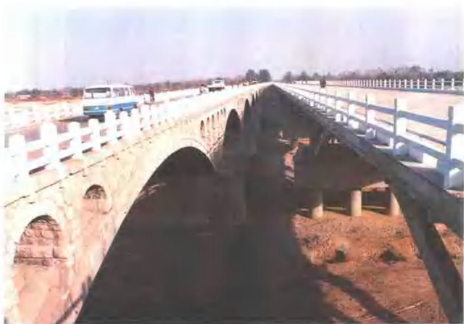
改建后的国道327兖州泗河大桥
