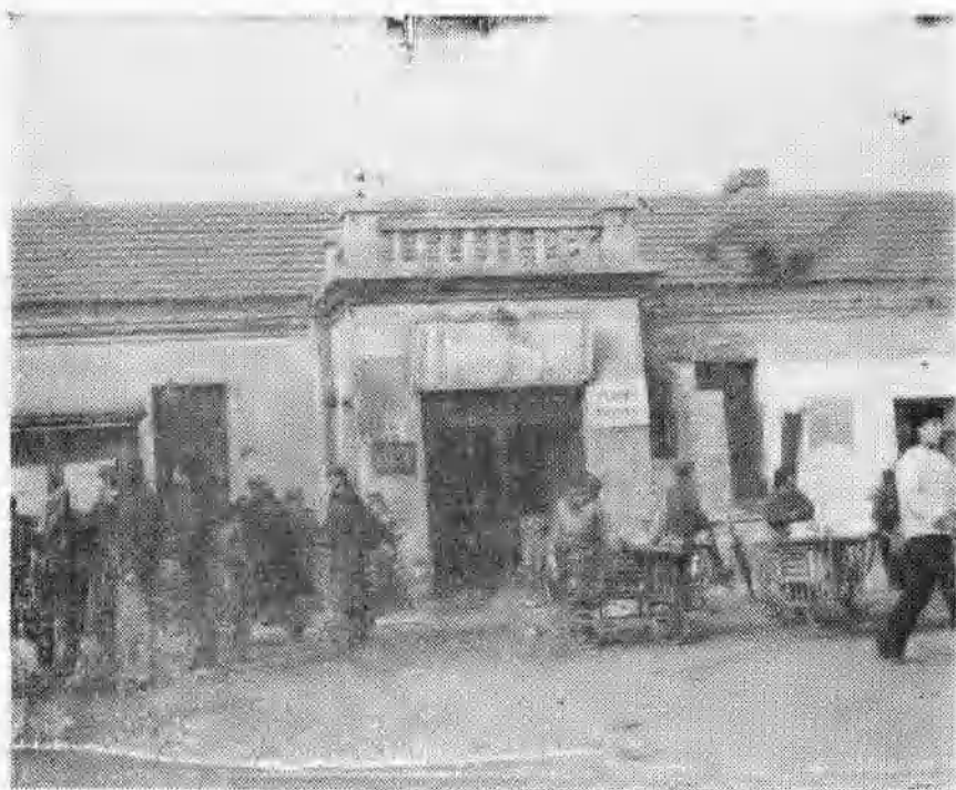
原淄川县邮电局营业室（火车站下1957年之前县邮电局）
