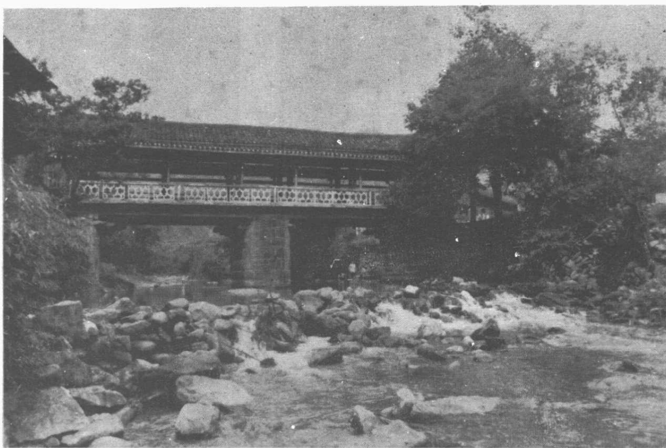
用民族经费支助修复一新的德旺风雨桥
